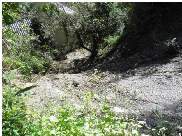
写真1 崩壊の地上部からの住宅裏の状況
