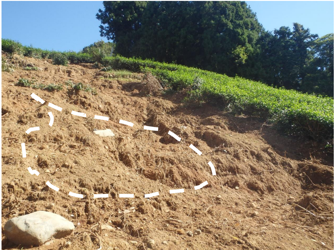
写真-4 : 地下水湧出痕～下方流下雨裂
